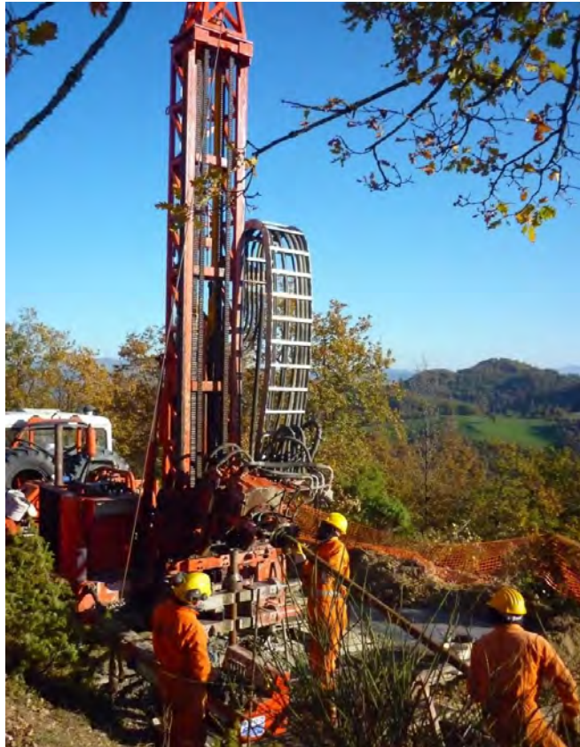
Perforazione di un pozzo per sismometro borehole.
