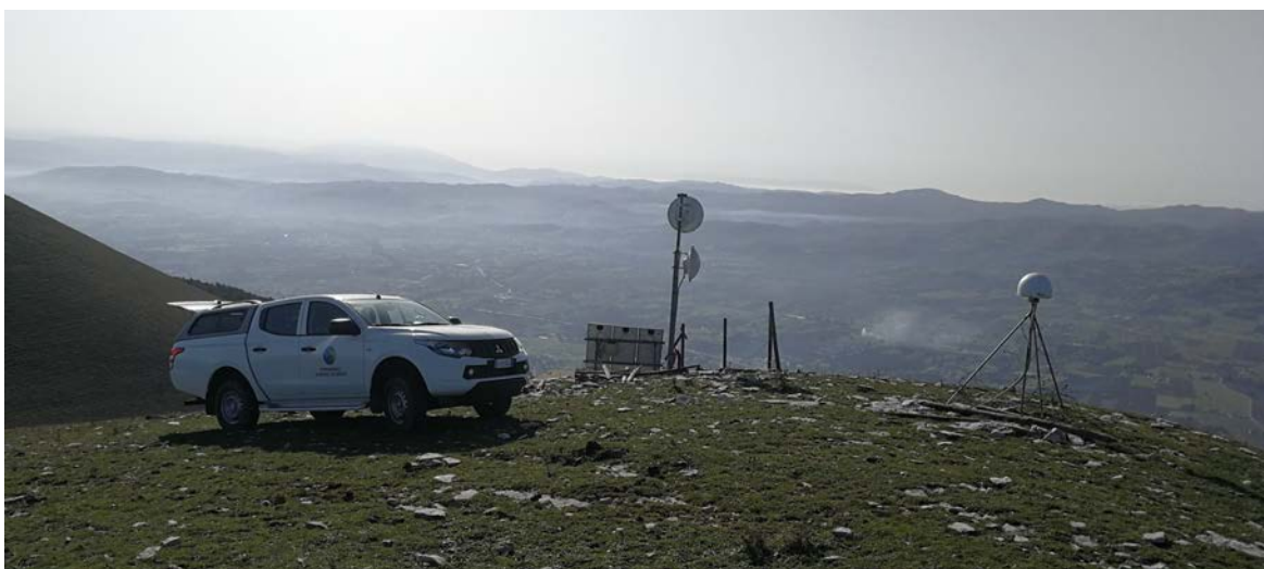
Figura 16.1 Allestimento della stazione multiparametrica ATFO Monte Foce, Rete TABOO.
