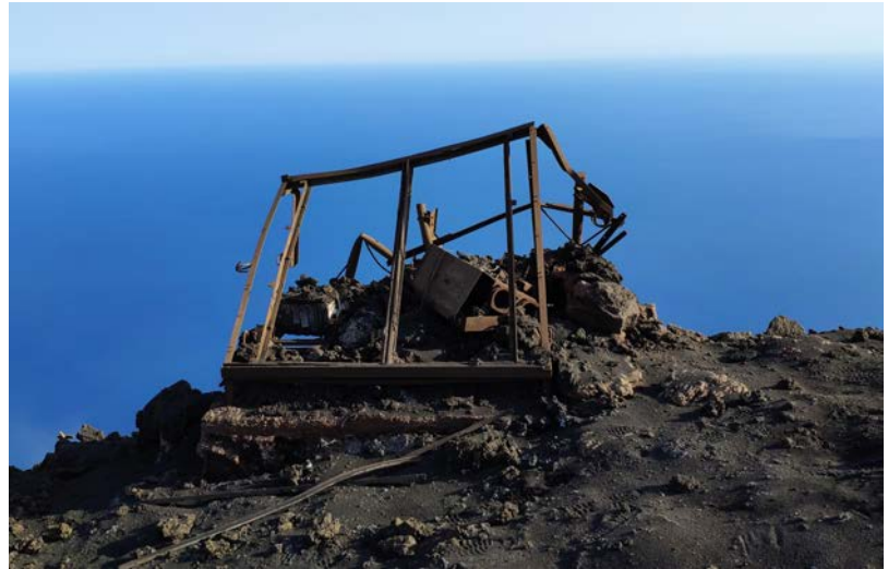
Figura 2.2.7 Stazione di videosorveglianza del Pizzo Sopra La Fossa di Stromboli distrutta dal parossismo del 3 luglio 2019.
