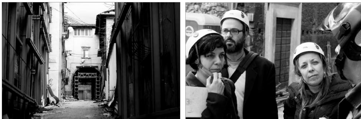
Figura 1 – Sopralluogo della troupe nel centro storico di L'Aquila (30 marzo 2010).
