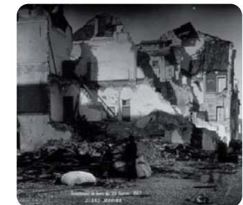
Danni a seguito del terremoto del 23 febbraio 1887
